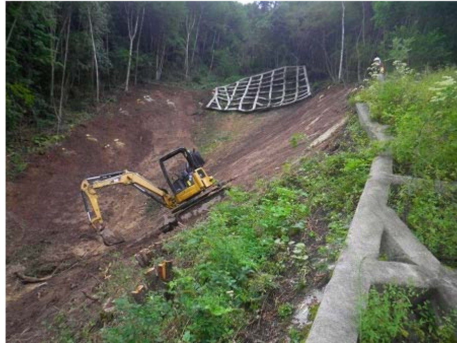
左岸法面の作業状況
