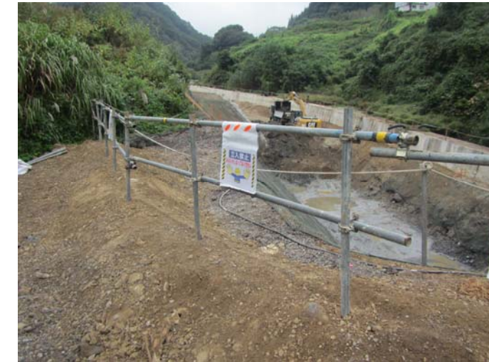
法肩区画状況
