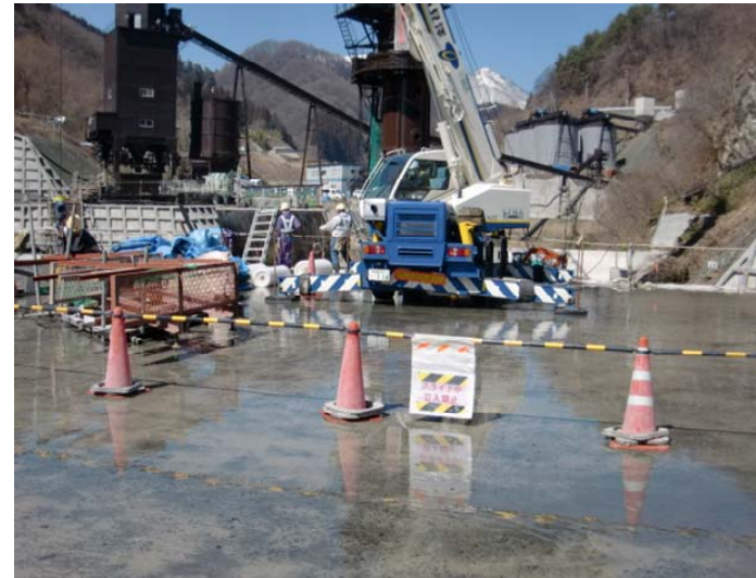
作業区画明示
