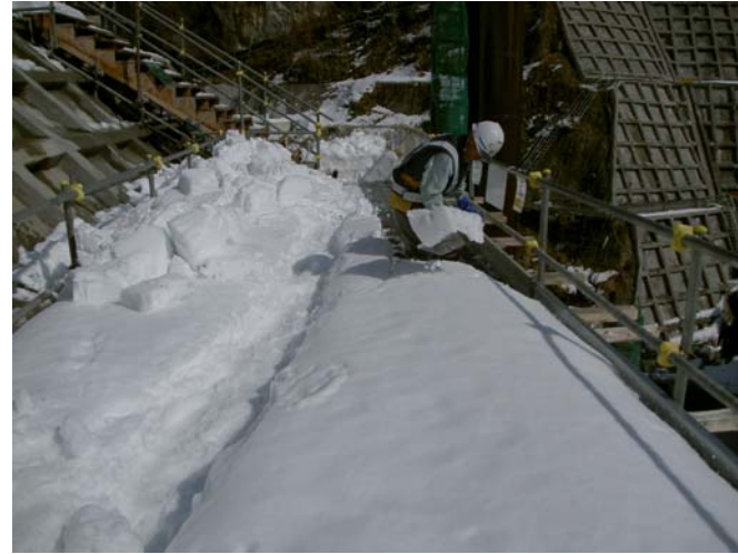
足場除雪状況
