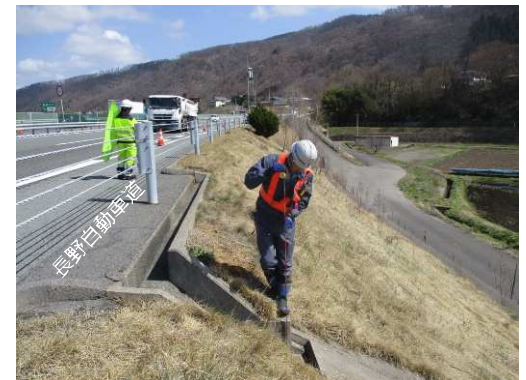
長野道上での測量(R5)
