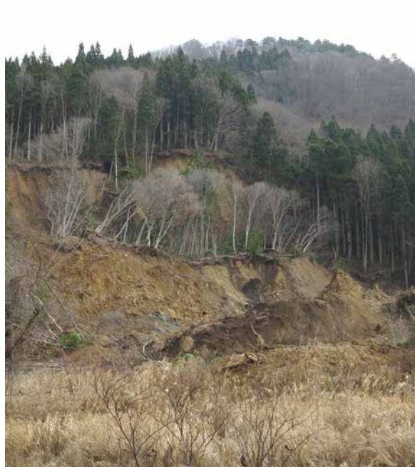
写真9 姫川東側で発生した崩壊。崩壊の原因は山腹で動いた断層（深空区）
