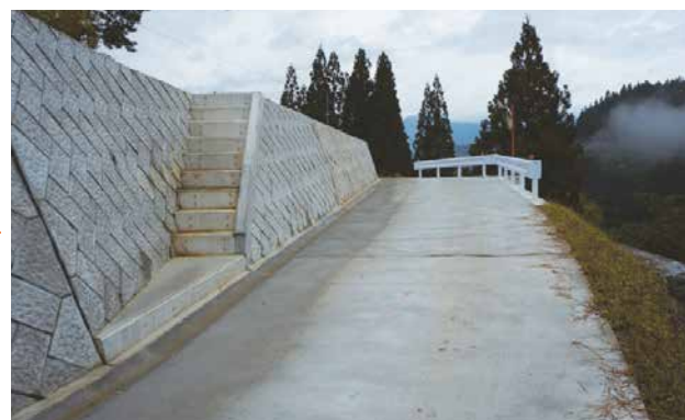
コンクリート舗装工で復旧された村道
