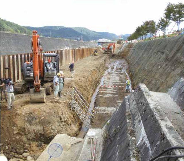
姫川護岸の復旧工事（飯田区）
