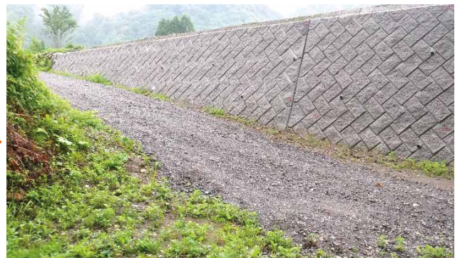
復旧した路面と擁壁
