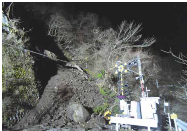
鉄道・踏切とともに村道滝の平線が被災
