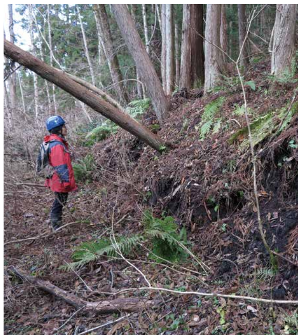
写真8 姫川東側の山腹に現れた撓曲（深空区）
