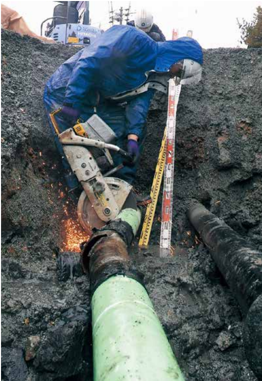
急ピッチで続く水道管の復旧作業 （『信濃毎日新聞』平成26年11月27日）
