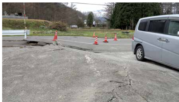
写真5 国道406号と駐車場に現れた断層（大出区）
