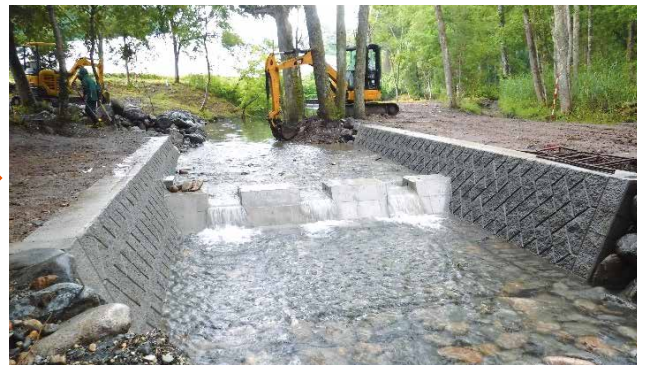
復旧した頭首工
