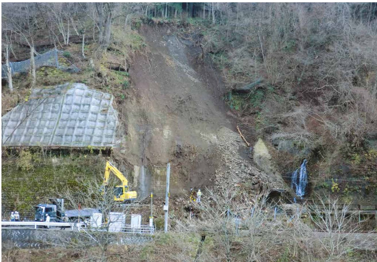
JR大糸線・滝の平踏切付近の崩壊
