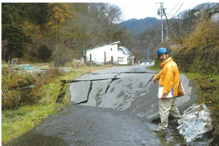
塩島区では断層が地表に現れ、道路と圃場に高さ約90cm、横に約30cmのずれ
