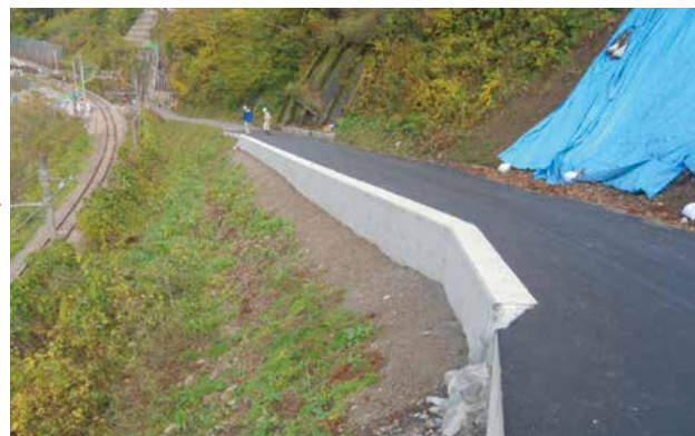
復旧が完了した滝の平線
