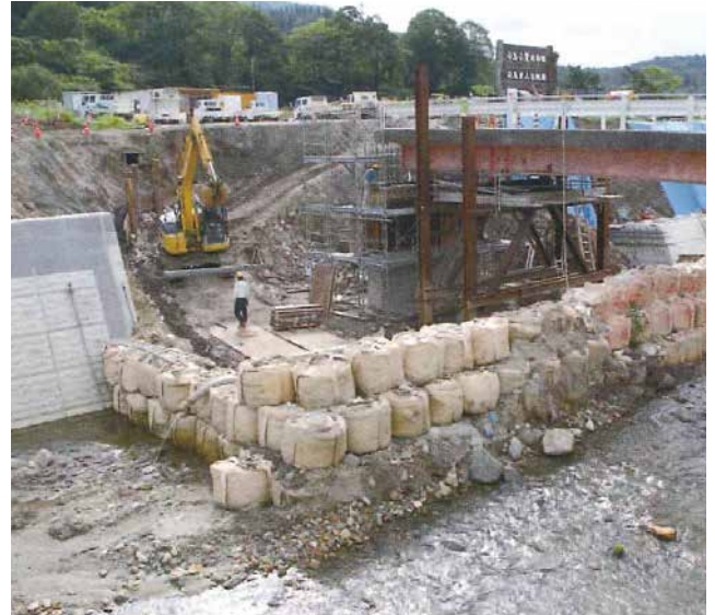
橋台と取付護岸の復旧（飯田区）
