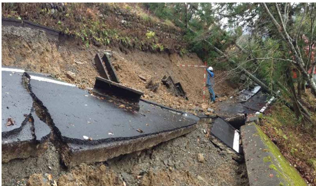
村道塩の久保線が地すべりで流出（八方岩集落）
