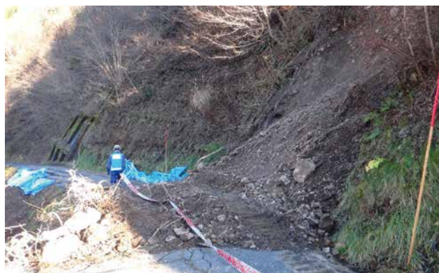
村道滝の平線は踏切上部でも土砂崩れ（滝の平）
