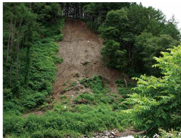
写真11 蕨平区に現れた神城断層。崩壊地やや上方の色調が異なる部分が断層
