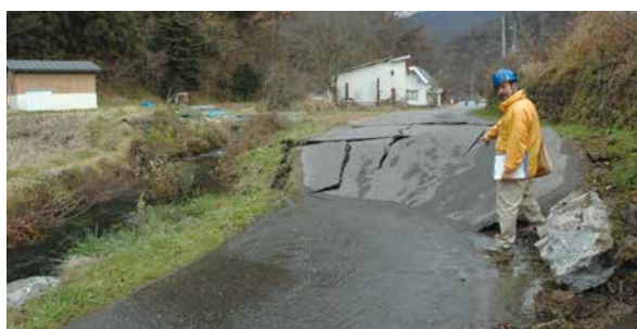
写真1 塩島区に現れた神城断層による撓曲（とうきよく）
