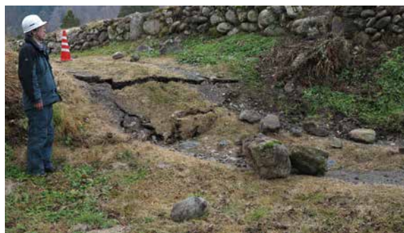
写真4 撓曲によって通行不能となった農道（大出区）
