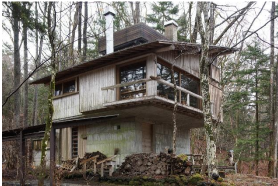
外観（南西から）
