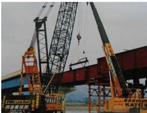
上部工（主桁）を架設中（昭和58年）
