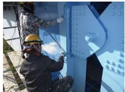
塗装作業の様子
