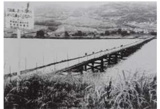
木橋の平和橋(昭和55年)看板には「自転車、オートバイはおりて通ってください」と表示。手すりがロープだけであり、川へ転落する危険があった。当然車の通行はできない。 (科野のいしぶみ五十周年記念誌 長野県建設業協会更埴支部)
