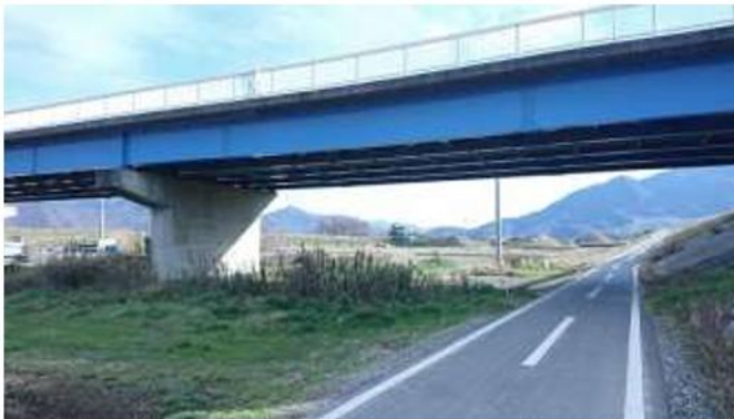
塗装終了部分（青色）と自転車道
