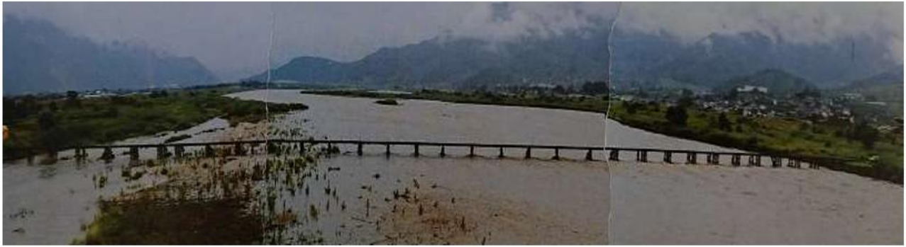
旧橋（木橋）の平和橋全景
