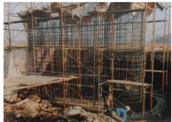
下部工 橋脚を施工中（昭和55年）
