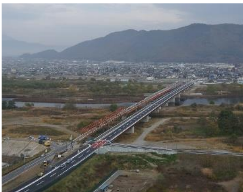
左岸側からの空撮、左側(下流)が旧橋。右側が新しい冠着橋 (平成 26 年 2014 年)
