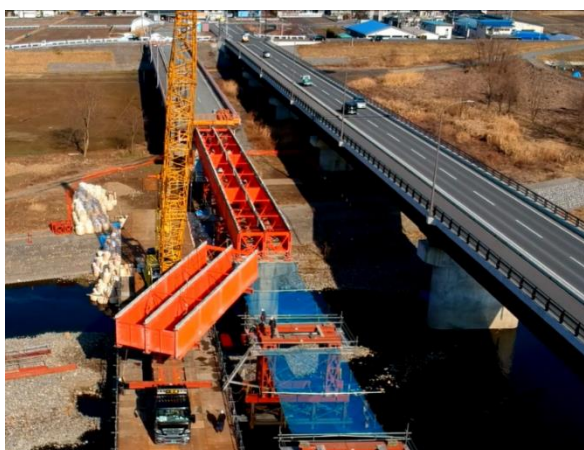
旧橋撤去工事の状況 (平成 29 年 2017 年)
