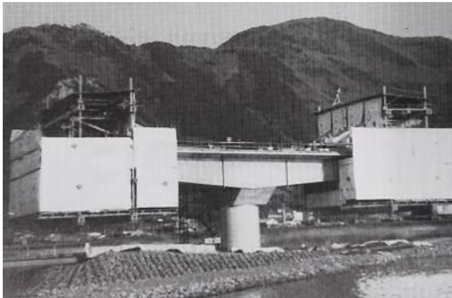
ディビダーク式カンチレバー工法で建設中の坂城大橋（昭和 60 年）「坂城町合併 50 周年記念写真で見る 20 世紀の坂城町」
