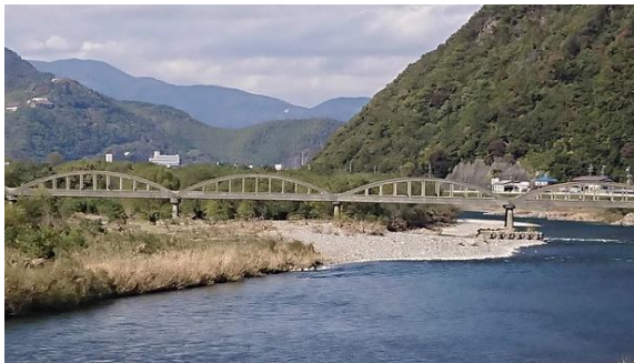
坂城大橋から見た昭和橋(右岸が国道18号)
