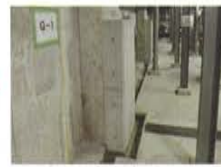
既設の柱を部分的に太くして、 耐震補強しました。
