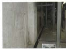
既設の柱を部分的に太くして、 耐震補強しました。
