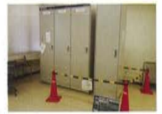
監視制御用の機器を 設置しました。
