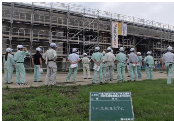
▲現場代理人から工事説明
