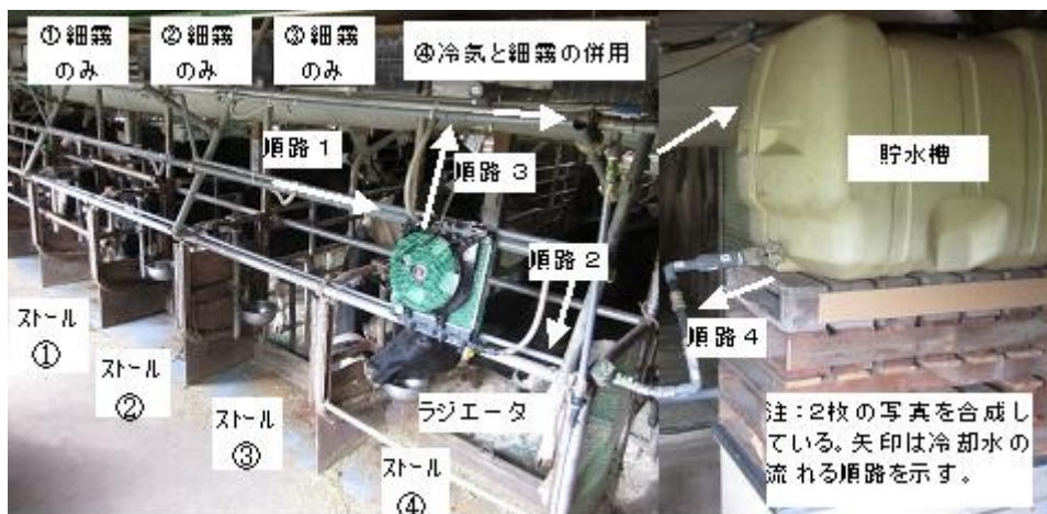
写真2 冷風機（4頭に1台の割合で冷風機を設置し排水を飲水利用したタイプ）
