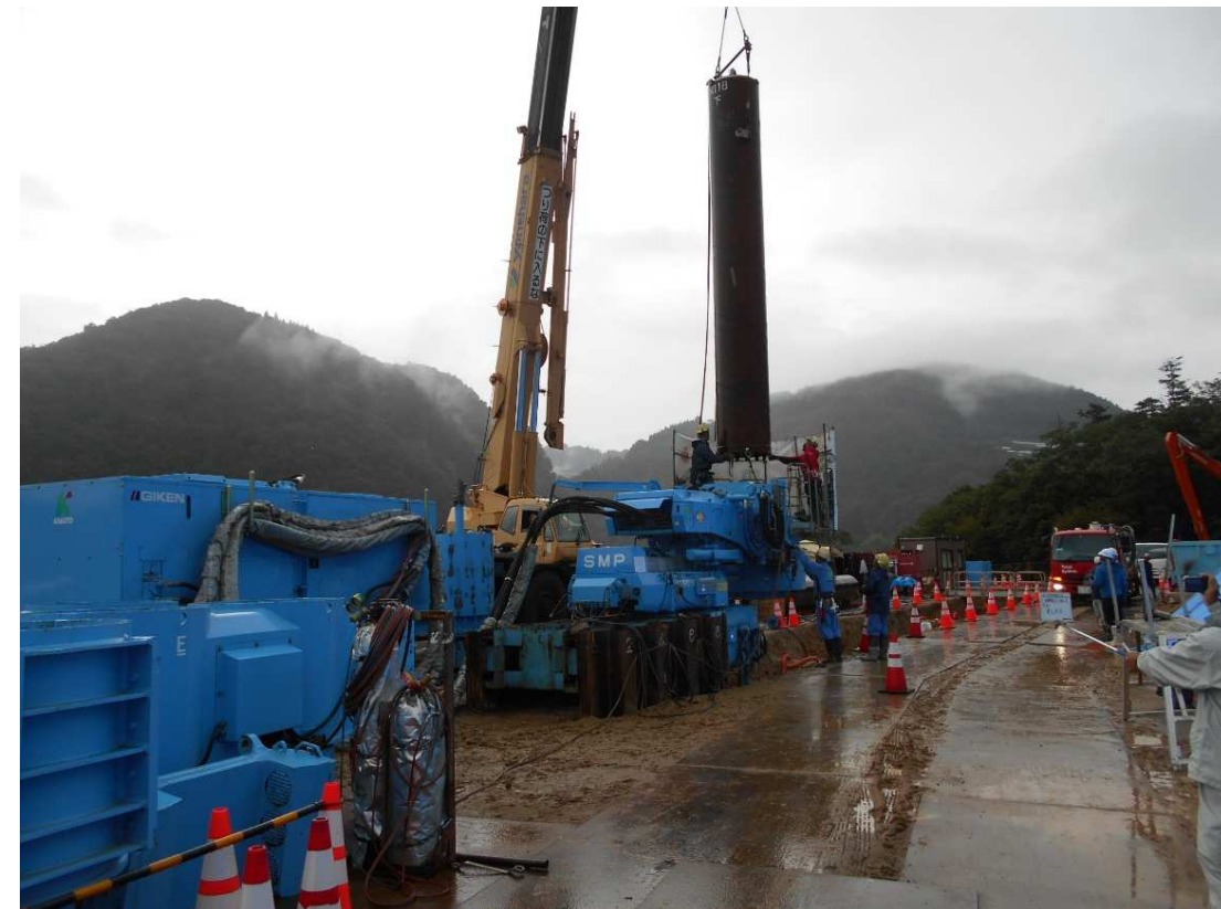
鋼管杭工 施工状況
