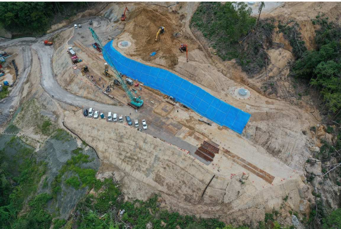
鋼管杭 工事用道路、施工ヤード
