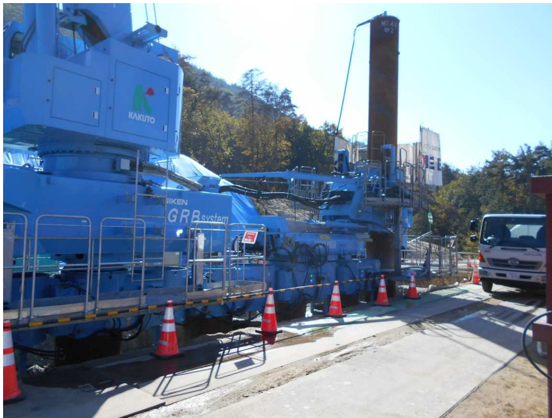
鋼管杭工 施工状況
