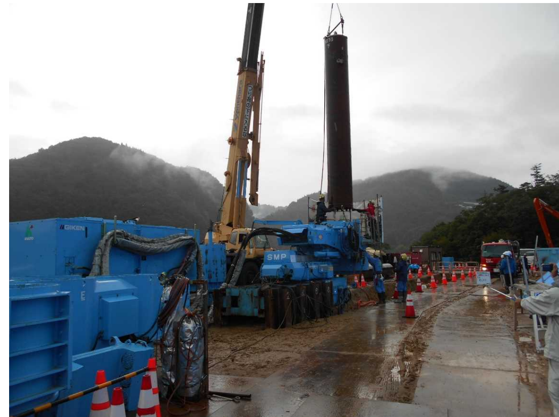
鋼管杭工 施工状況
