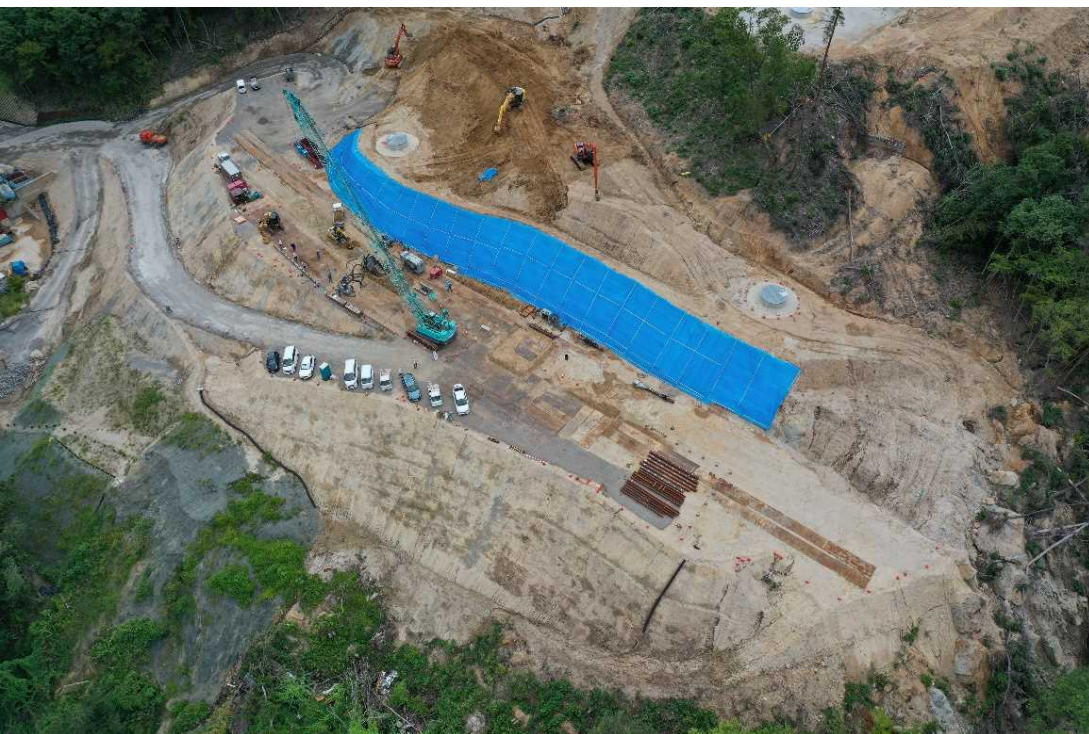
鋼管杭 工事用道路、施工ヤード
