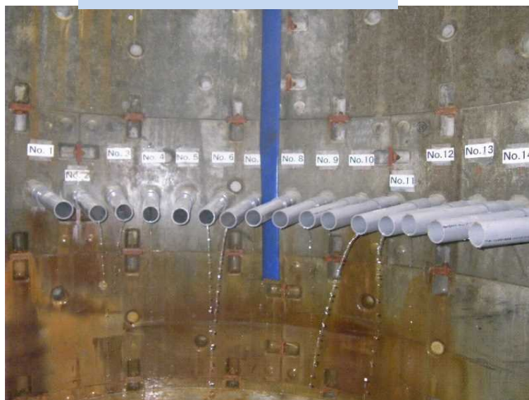
集水ボーリング施工完了
