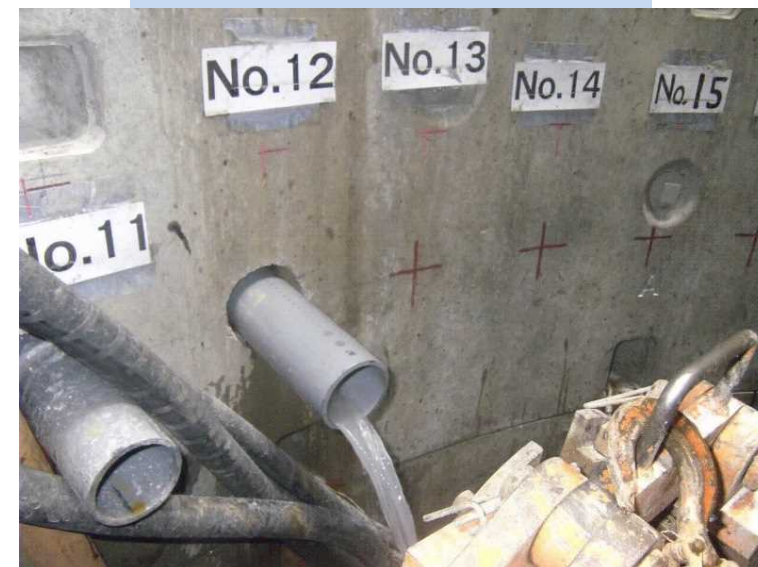
水抜きパイプから湧水の状況
