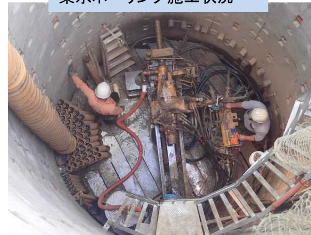
集水ボーリング施工状況
