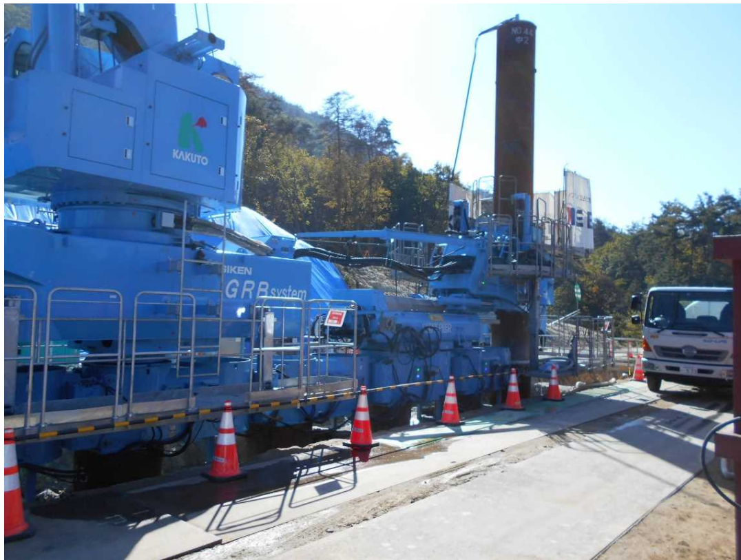
鋼管杭工 施工状況
