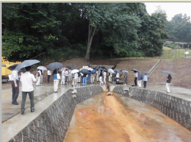
排水トンネルと水路（鉄さびによる赤水）
