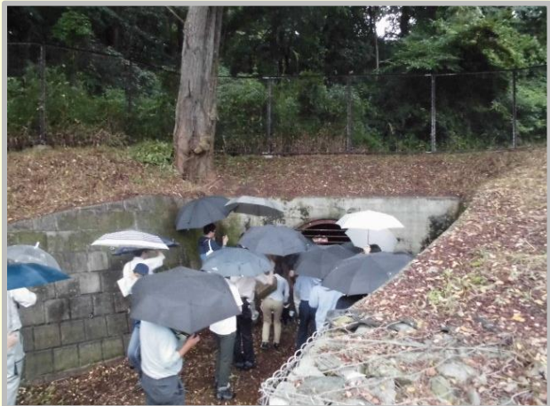
第1号排水トンネル抗口にて
