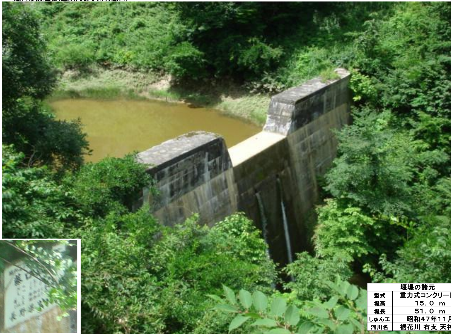
藤口砂防堰堤(上水内郡小川村藤口)
