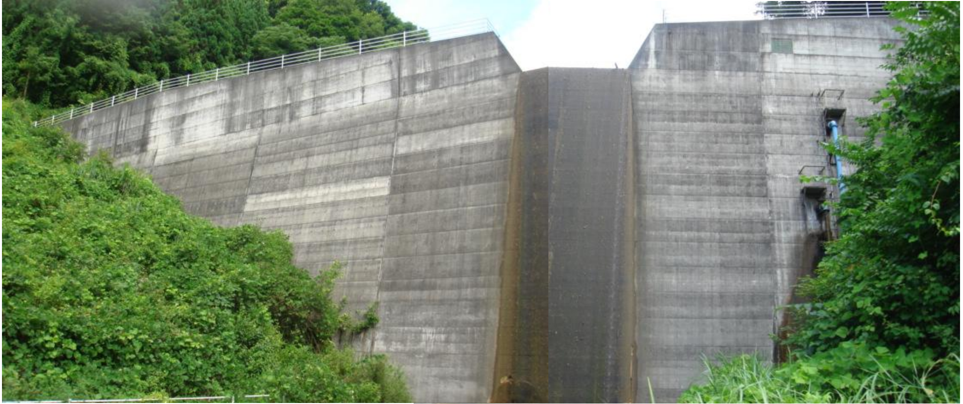
絹張砂防堰堤(上水内郡小川村絹張)
