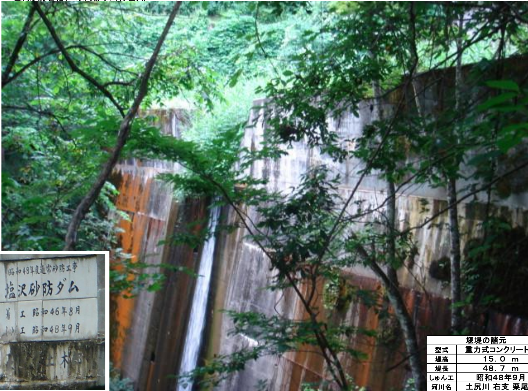
塩沢砂防堰堤(上水内郡小川村塩沢)
