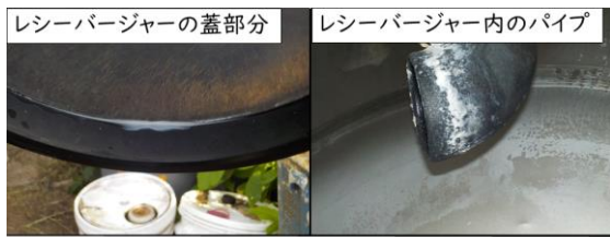
図7 レシーバージャー内部の汚れ
