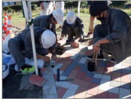
施工 | 講師 長野県建設業協会
