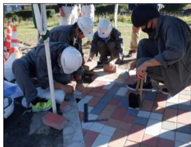
施工 | 講師 長野県建設業協会
