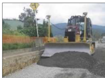
ICT建設機械による自動施工、作業の省力化（測量・丁張・誘導員などが不要）
