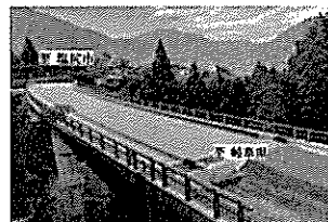
災害時における道路の迂回機能強化事業 木曾川右岸道路 田立大橋
