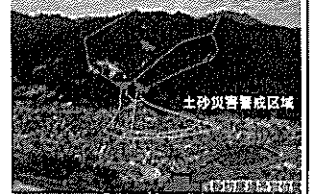
流域を保全する土砂災害対策事業 長野市 安茂里(砂防堰堤)
