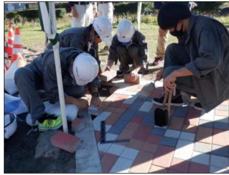
施工 | 講師 長野県建設業協会
