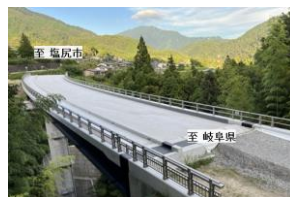
災害時における道路の迂回機能強化事業 木曾川右岸道路 田立大橋
