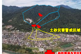
流域を保全する土砂災害対策事業 長野市 安茂里(砂防堰堤)
