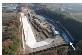
流域治水対策事業 (一)黒沢川 安曇野市 黒沢(調節池)
