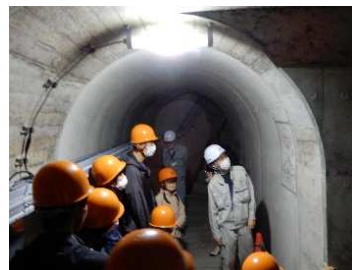
普段は入れないダム内部の見学
