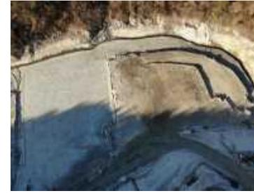
ベンチカット工法での掘削状況
