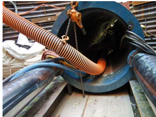
立坑内から見る函渠
