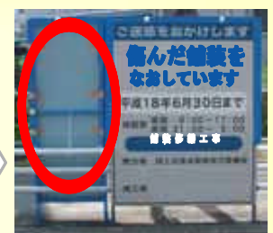
工事説明看板が歩行者に対し設置されている。
