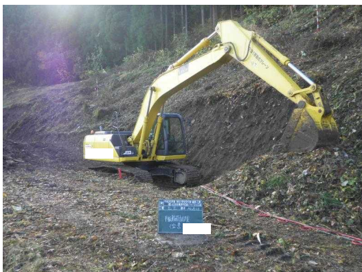
平板載荷試験の実施状況
