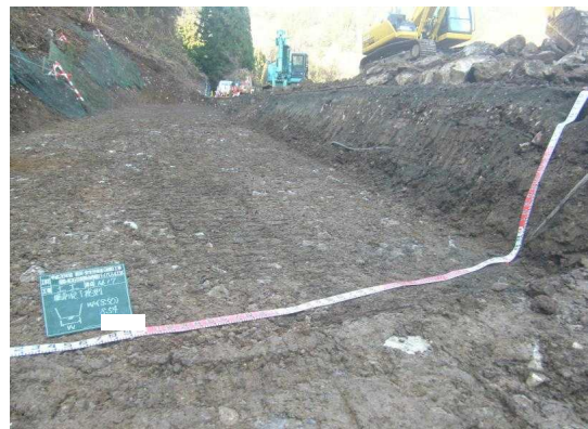
置換基礎の施工基面
