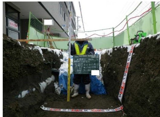
掘削断面内の埋設管状況
