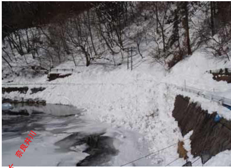
H26.2 雪崩による管理用通路の埋塞状況
