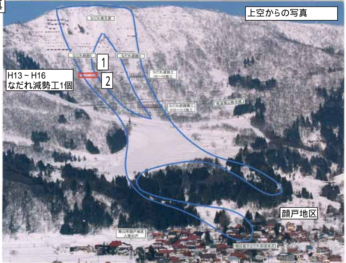
施工後(現況)写真
