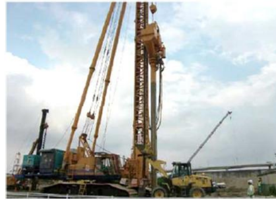
軟弱地盤処理工
