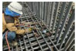
ガス圧接継手
