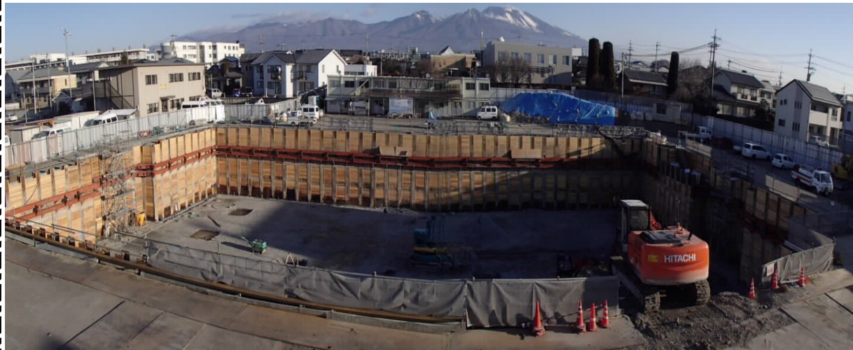
【②親杭腹起アースアンカー工法】
