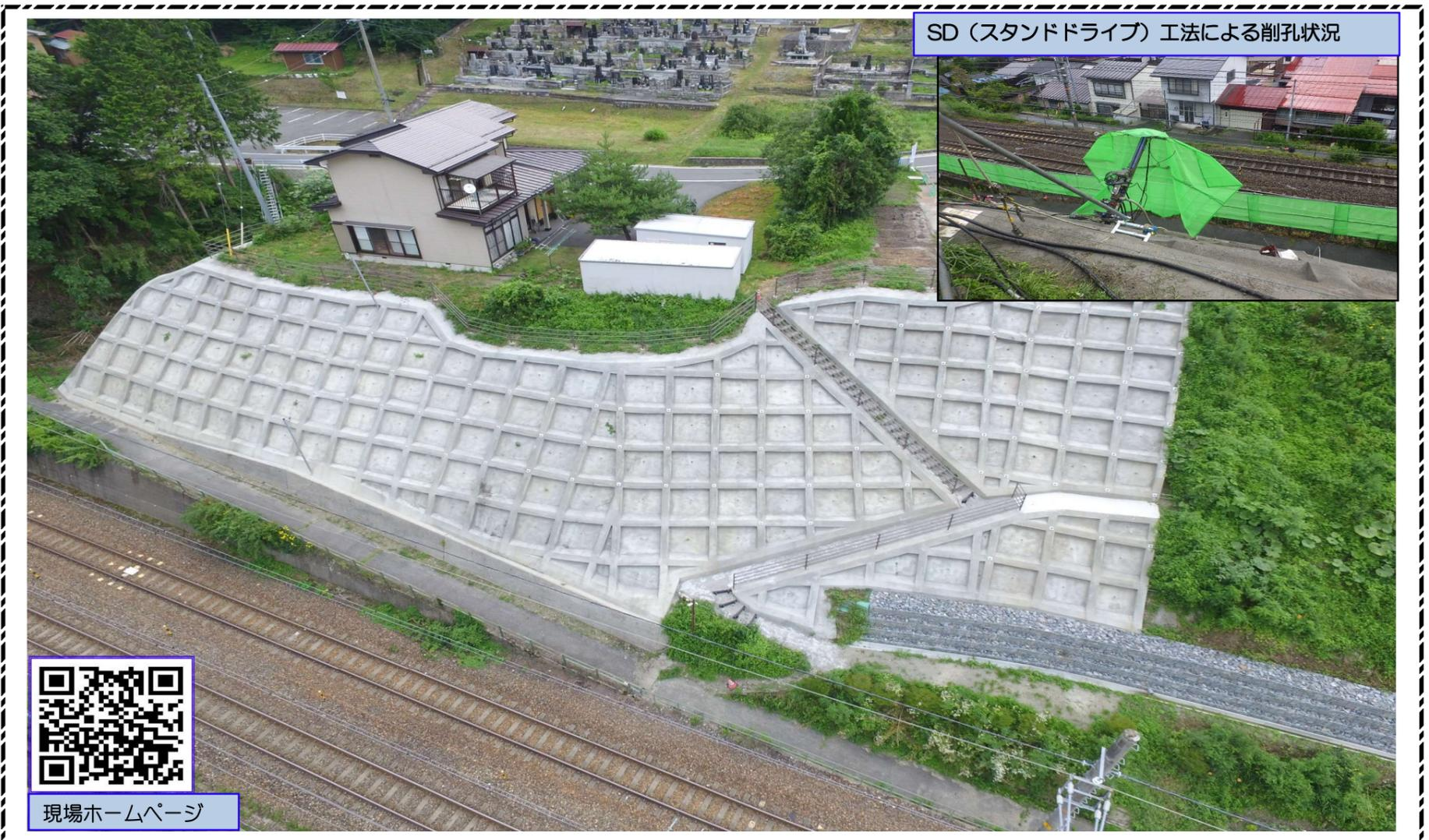
SD（スタンドドライブ）工法による削孔状況
