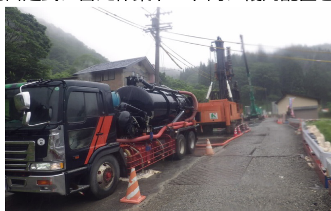
作業ヤード | 迂回スペース
