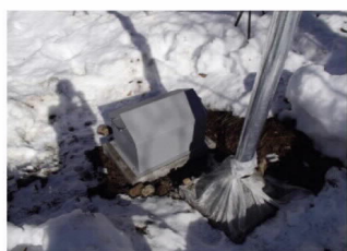
基礎コンクリート上の鋼製ボックス
