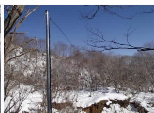
中継ポールと空中架線
