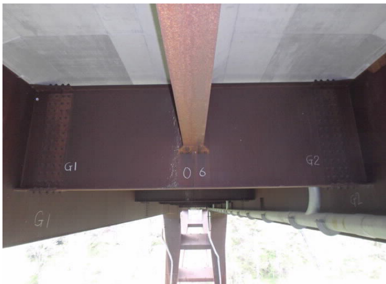
写真1. 部材へのチョーキングの例
