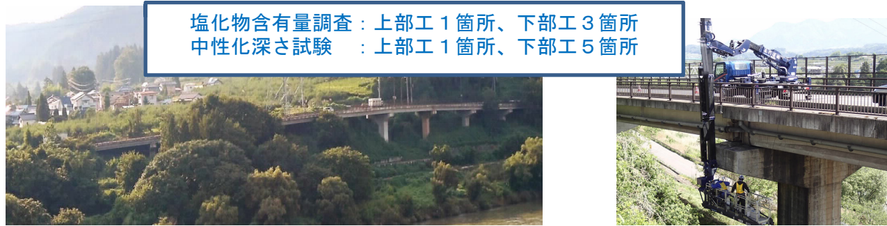
写 - 1 業務対象橋梁<3径間連結PCホースパルブT桁橋(3連)>
