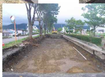
ICT建機による掘削状況
