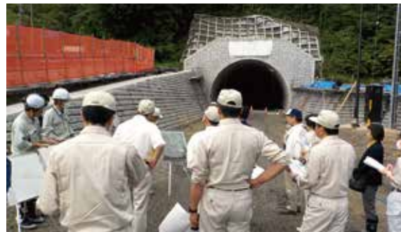
下條村粒良脇トンネルの調査
