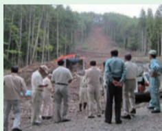
復旧治山事業の調査
