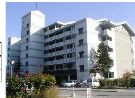
公営住宅管理: 県営住宅稲荷山団地 (千曲市)
