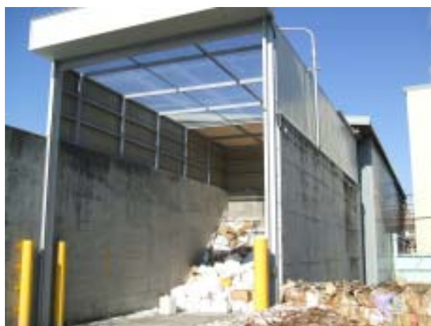
製紙工場に設置された機密文書専用保管庫 管理者が使用時にシャッターを開閉する 写真提供：王子板紙株式会社松本工場（長野県松本市）
