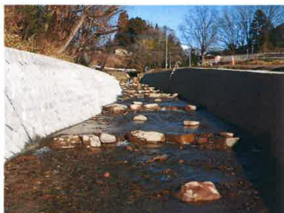
【現場発生材利用例】 発生石材利用による河床洗堀防止対策
