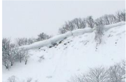
巻だれ 雪崩防止柵からの雪の張り出し
