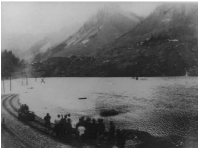
この崩壊によって、姫川がせき止められ国鉄大系線が300m埋没。
