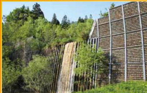
濁沢李平 鋼製枠堰堤
