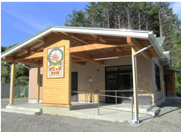
専用の工場を新築で建設しました
