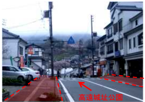
歩道の段差解消
