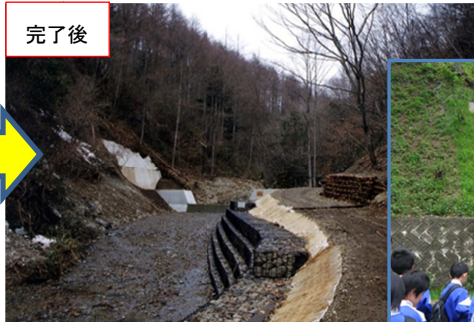
↓ 施工後の状況
