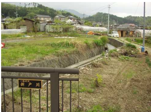
↓施工前の状況
