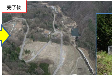
↓施工後の状況
