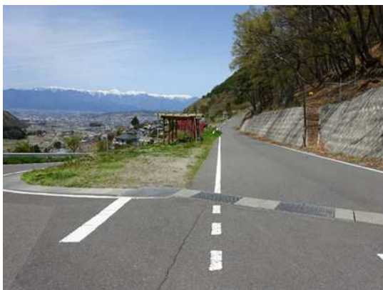
↓施工後の状況
