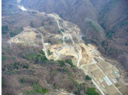
↓施工前の被災状況
