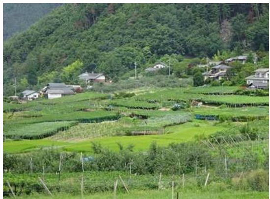
↓施工後の状況
