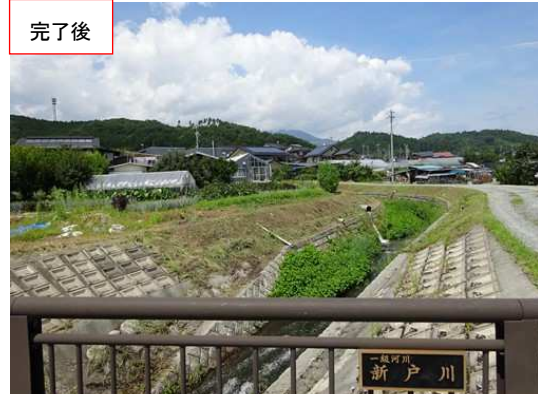
↓施工後の状況
