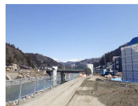
施工状況（2019年3月現在）
