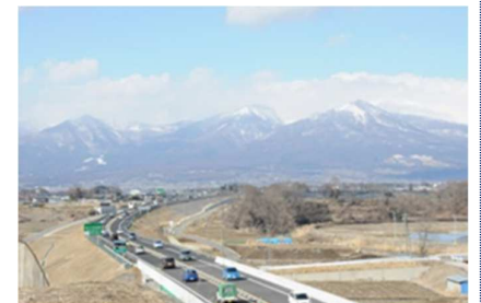
(中部横断自動車道)
