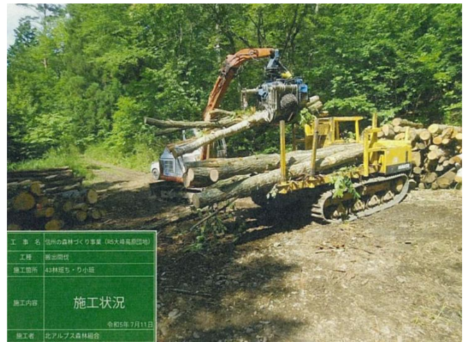
搬出作業状況
