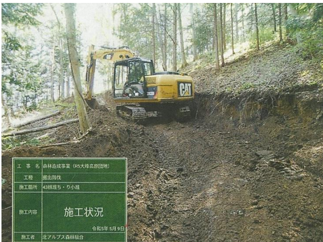
森林作業道開設状況
