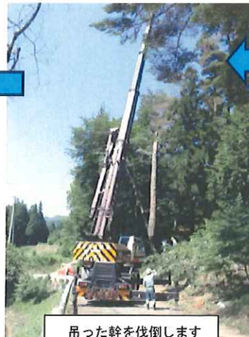
吊った幹を伐倒します
