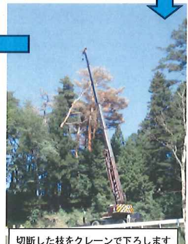
切断した枝をクレーンで下ろします
