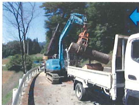
伐採した木を短く切って運び出し、虫を殺すための薬剤処理をします
