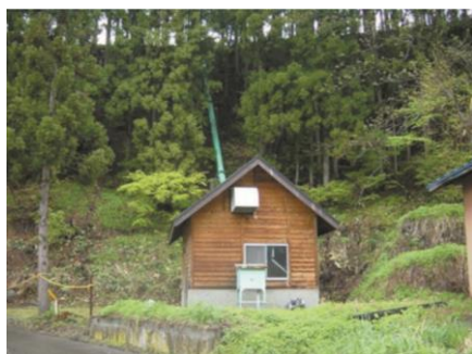
馬曲川水力発電所
